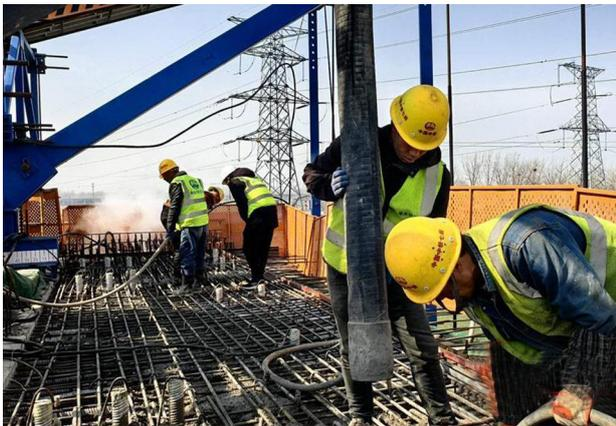
3月18日,经过连续9小时的日夜奋战,雄商高铁跨商周高速连续梁2号块混凝土浇筑成功完成,这标志着连续梁正式进入标准节施工阶段后又一步进展,为后期箱梁铺架奠定了坚实的基础,为2024年项目建设的有序推进按下了“加速键”。
